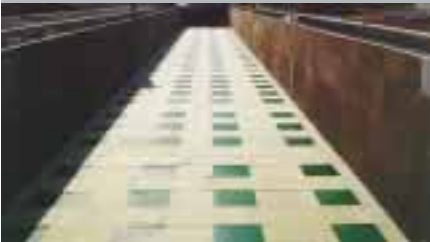
Bild 2: Nach Montage der Isolation (grün)
