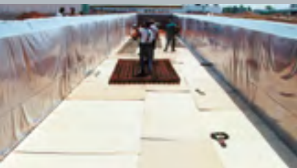
Figura 3: Preparación del colado de la cimentación
