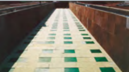
Figura 2: Tras el montaje del aislamiento (verde)
