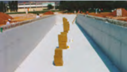
Figura 1: Taza de cimentación antes del montaje de las placas antivibratorias
