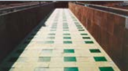
Bild 2: Nach Montage der Isolation (grün)
