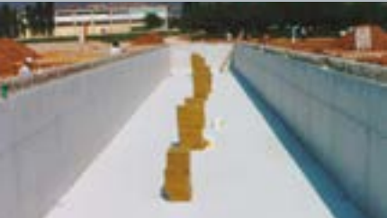
Bild 1: Fundamentwanne vor Montage der Schwingungsisolationsplatten
